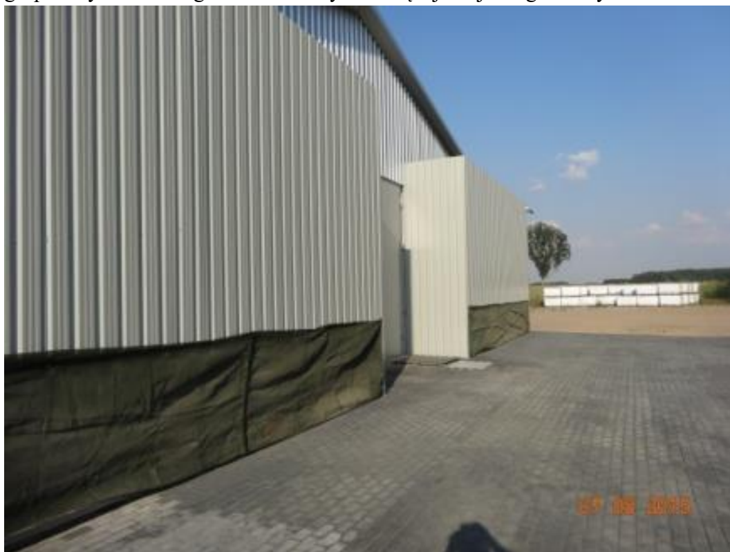
Ryc. 10. Sposób obudowania wentylatorów szczytowych
