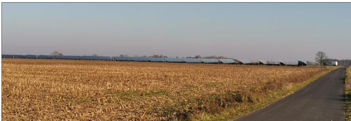
Rys. 18 Zdjęcie elektrowni fotowoltaicznej z odległości ok. 200 metrów (Źródło: Materiały własne)
