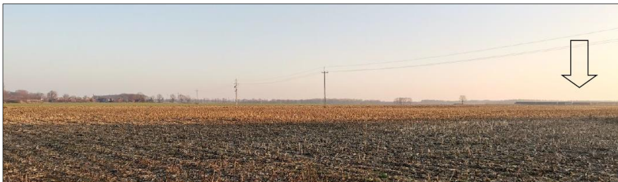
Rys. 19 Zdjęcie elektrowni fotowoltaicznej z odległości ok. 450 metrów (Źródło: Materiały własne)
