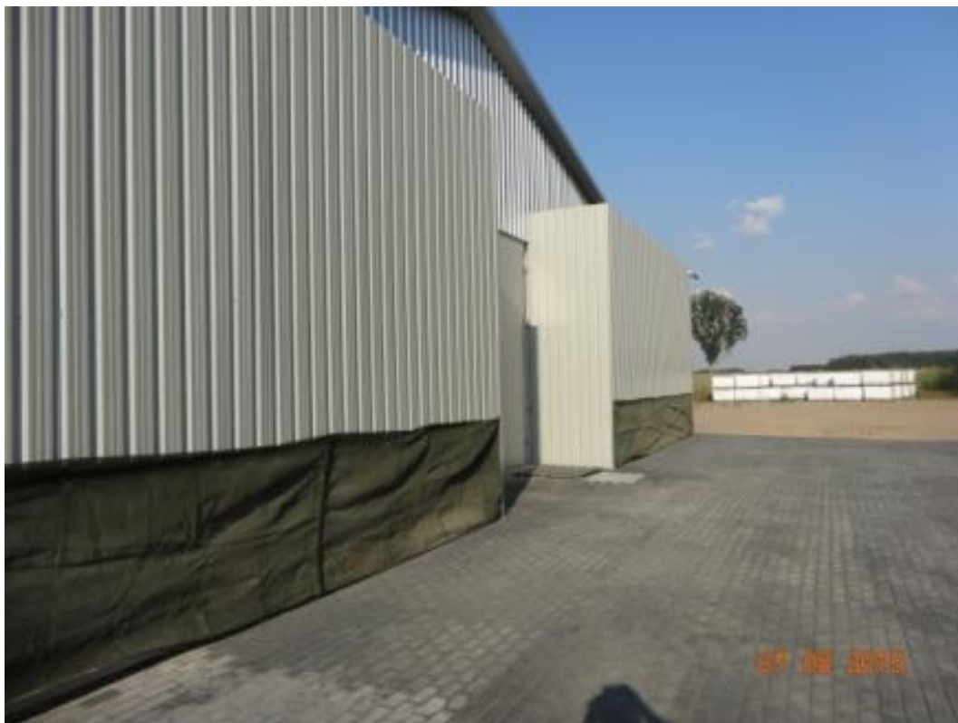
Rysunek 11. Sposób obudowania wentylatorów szczytowych
