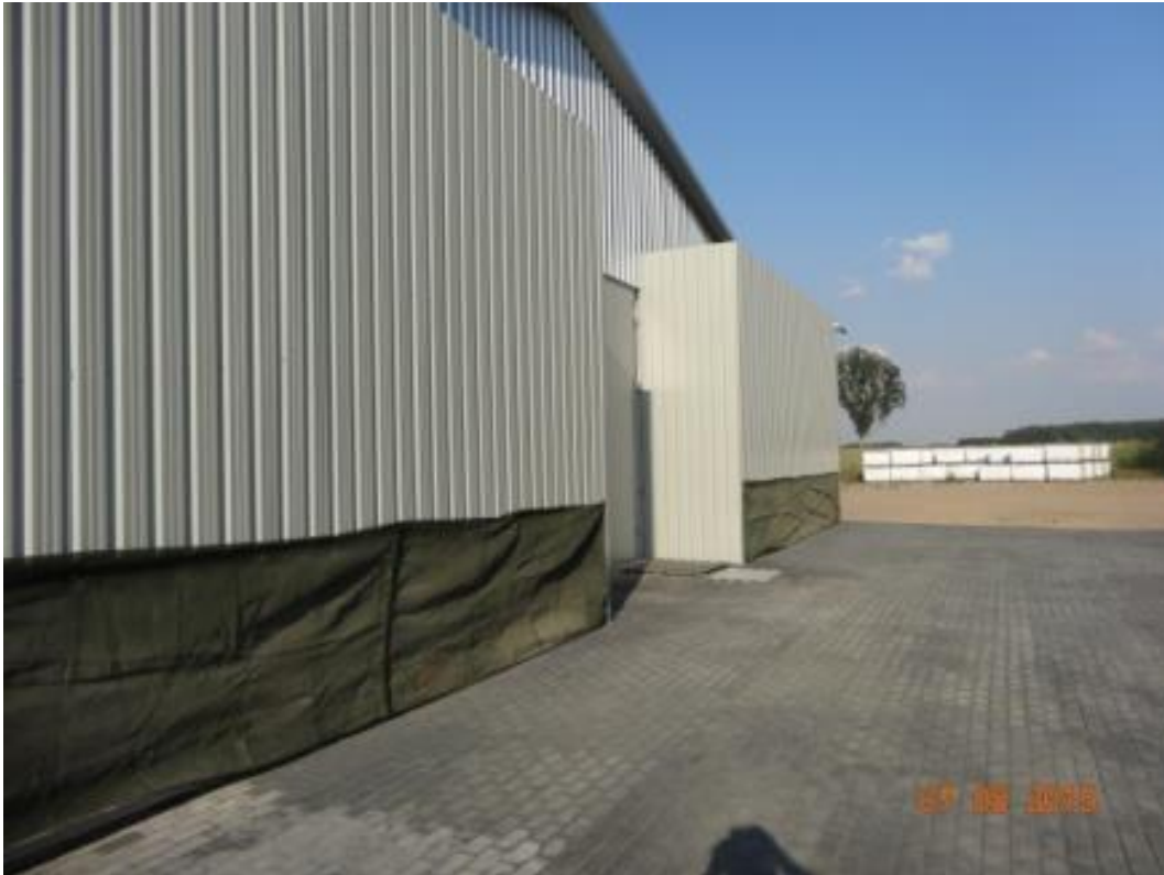
Rysunek 7. Sposób obudowania wentylatorów szczytowych
