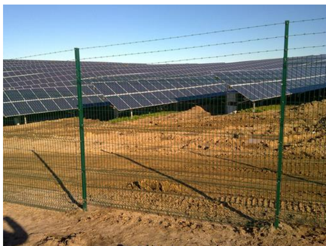
Fotografia 2 Przykładowe ogrodzenie dla elektrowni fotowoltaicznej
