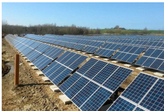
RYSUNEK 9. KONSTRUKCJA POŁUDNIOWA ZE STOPAMI FUNDAMENTOWYMI
